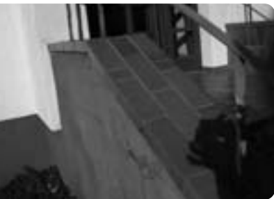
Treppe und Geländer am südlichen Ausgang Foto: Ute Hölle
